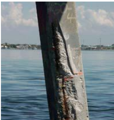
Rysunek 5. Korozja stali zbrojeniowej w konstrukcjach betonowych [K2]
